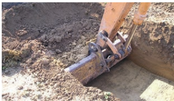
Fig. 2.3: Scavo di un profilo con miniescavatore, in pianura.
